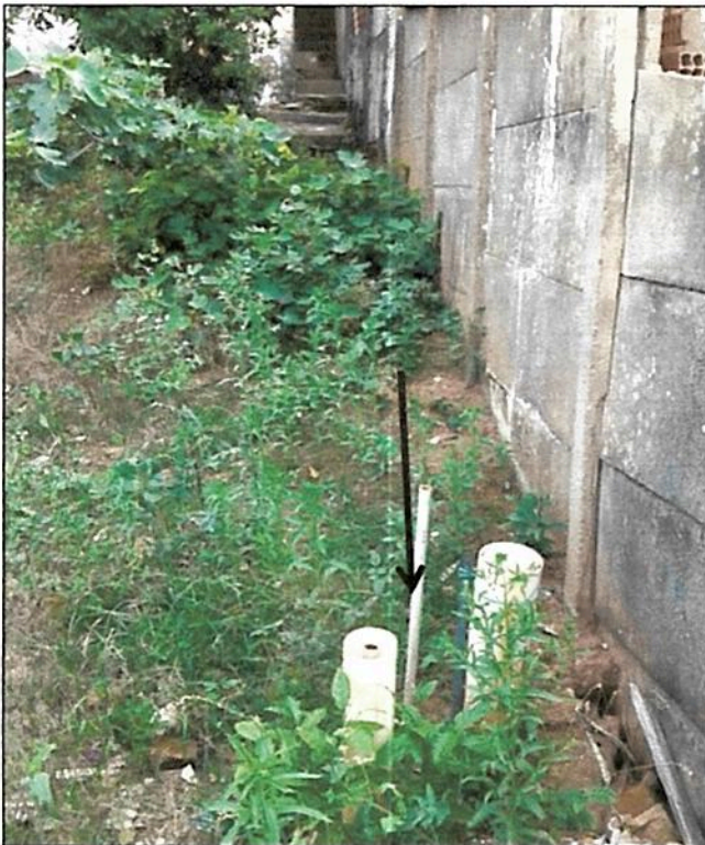
Imagem 04: Vista do Poço Manual/Cisterna, o qual foi cadastrado em 2003, para abastecimento temporário do Posto São Cristóvão na atividade de lavagem de veículos.
