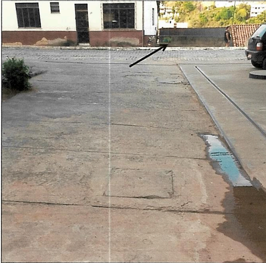
Imagem 03: Vista da área do antigo lavador de veículos desativado. Destaque para o terreno do lado oposto à Rua Laudelino Barbosa, onde está localizado o poço manual/cisterna que abasteceu temporariamente o Posto São Cristóvão.
