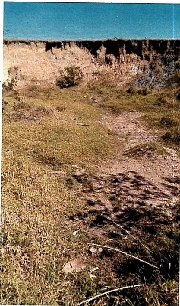
FOTO 03- Foco erosivo no terreno
