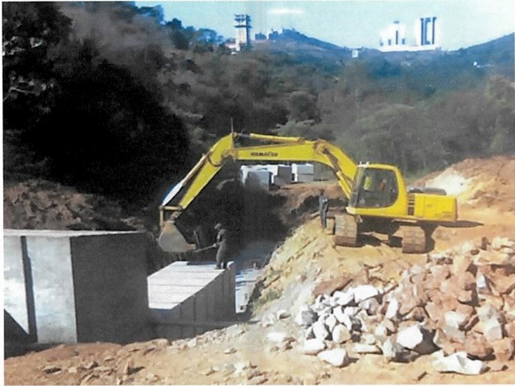
IMPLEMENTAÇÃO DE GALERIA COM REDUTOR DE ENERGIA
