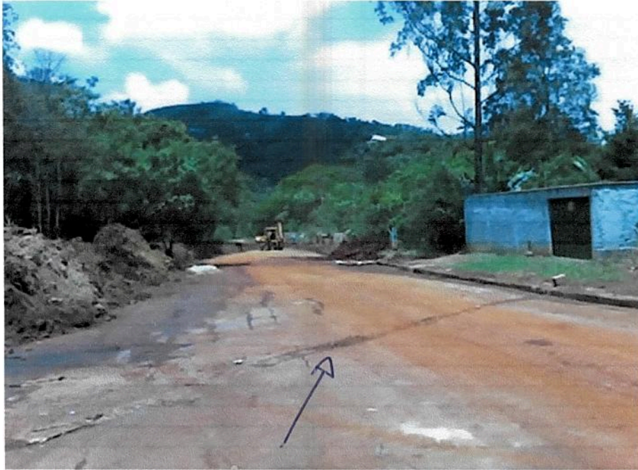
SITUAÇÃO ANTERIOR CORTE NA RUA PARA EXPOR AS MANIFOLDAS
