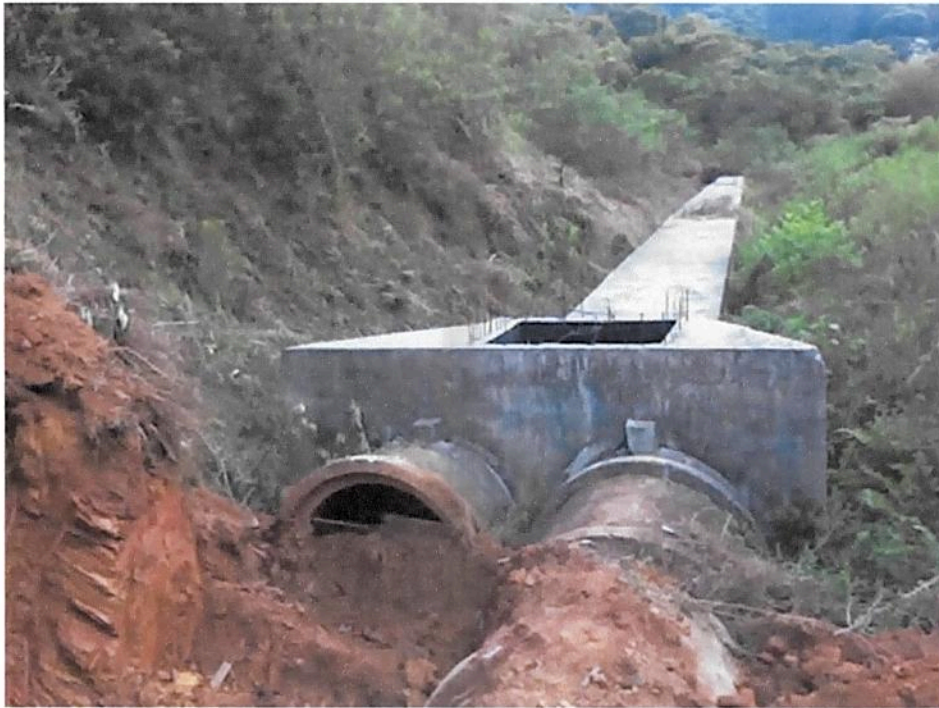
SUBSTITUIÇÃO DE MANIFOLDAS
