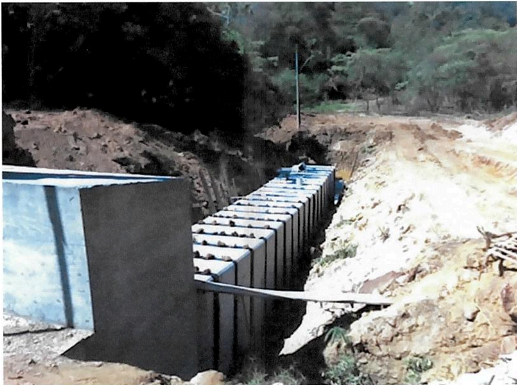
IMPLEMENTAÇÃO DE GALERIA COM REDUTOR DE ENERGIA
