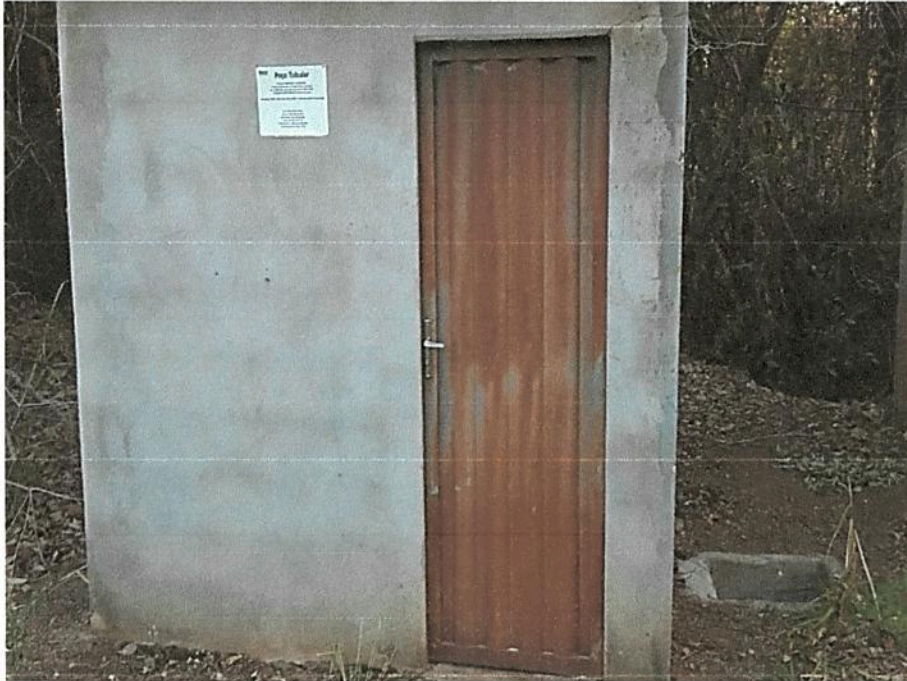
Foto 1- Casa de proteção do poço tubular.
